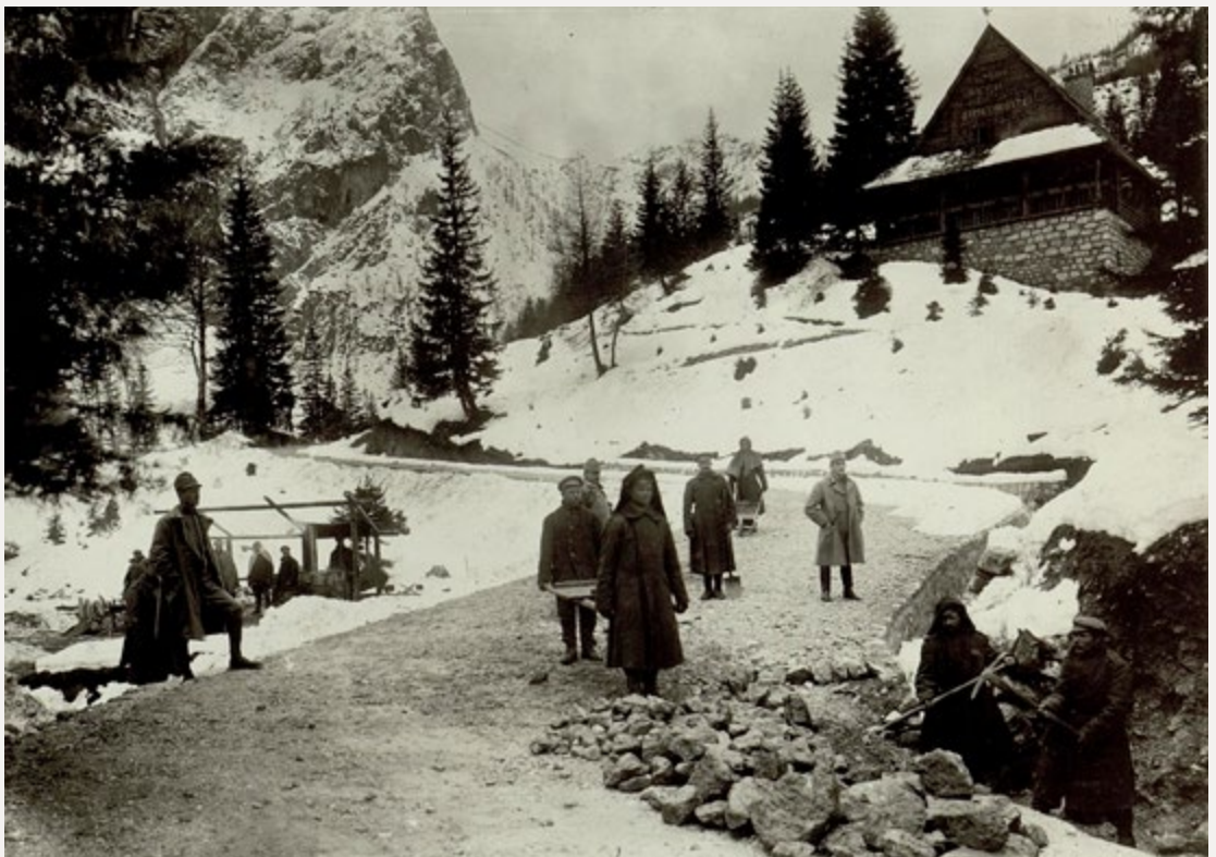
Fotografija 5: Ruski ujetniki pri gradnji vršiške ceste.
