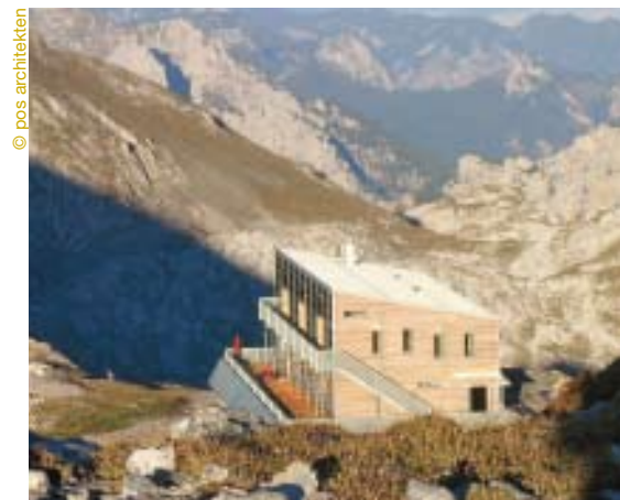
Velika zastekljena fasada na južni strani koče Schiestl optimalno izkorišča toploto sonca.
