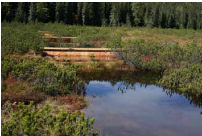
Sanierungsmaßnahmen im Ramsar-Gebiet Autertal
