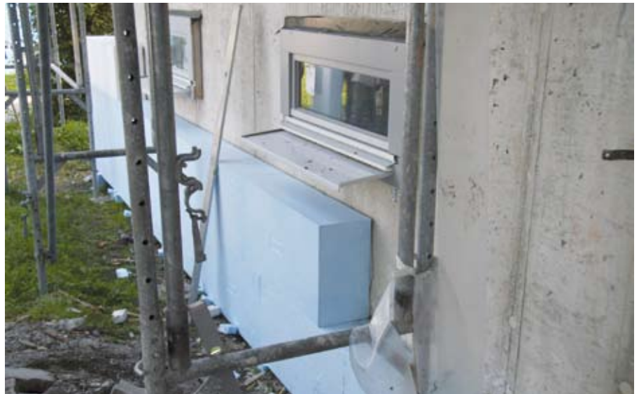
25 cm dicke Dämmplatten an der Außenwand eines Hauses bedeuten ein großes Einsparungspotenzial beim Energieverbrauch.
