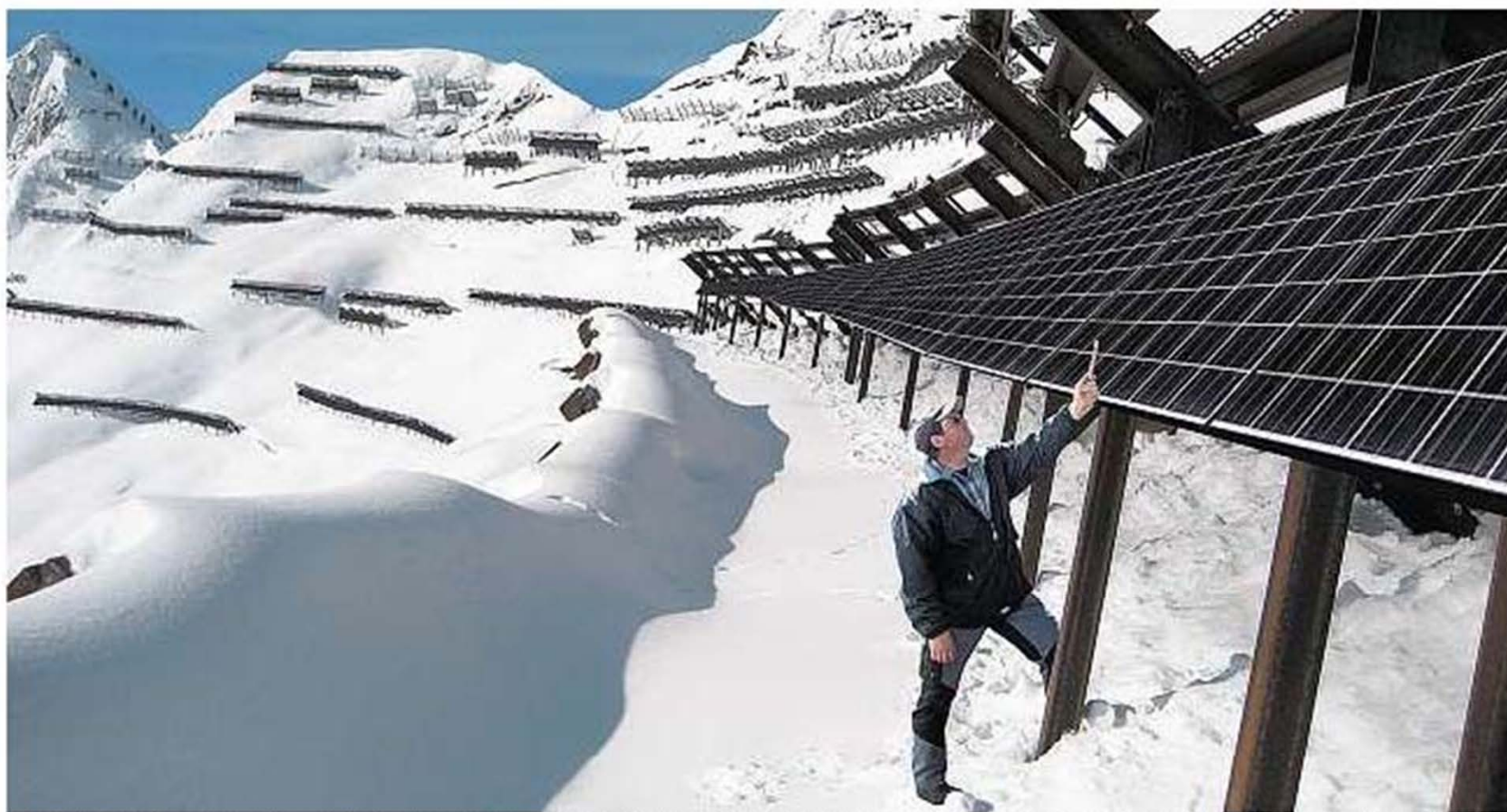
Ein Kraftwerk im Schnee: Auf den Lawinerverbauungen am St. Antonier Chuenihorn sollen 30 000 Quadratmeter Solarpanels Strom liefern. Visualisierung Energiebüro
