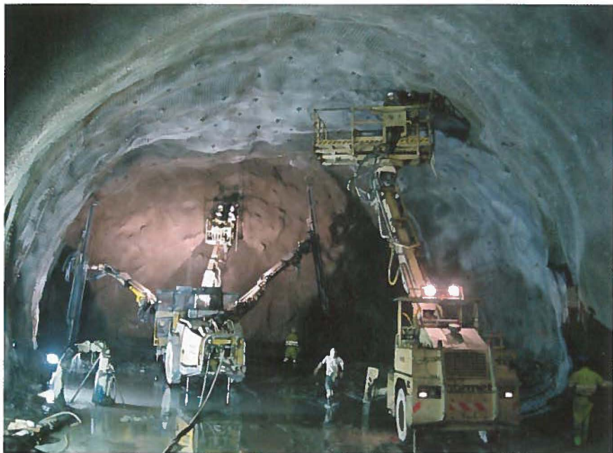
▲ Creusement de la galerie de reconnaissance de Villarodin-Bourget. © LTF
