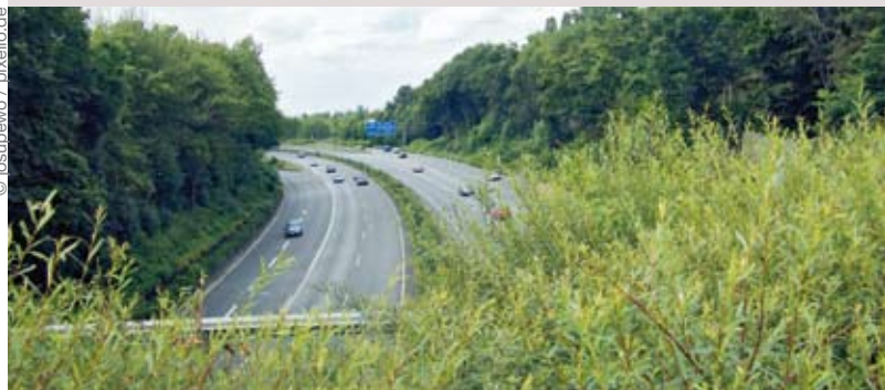
Verkehrswege sind Wanderhindernisse: Tiefblick von einem Grünkorrridor auf die überbrückte Autobahn.
