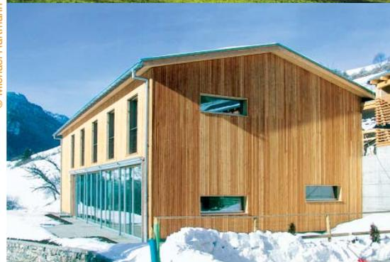
**Casa passiva:** fabbisogno energetico inferiore a 15 kWh/m<sup>2</sup>a, ottenuto mediante isolamento termico, sfruttamento passivo dell'energia solare e ventilazione con ricircolo del calore. [www.passiv.de](http://www.passiv.de)
