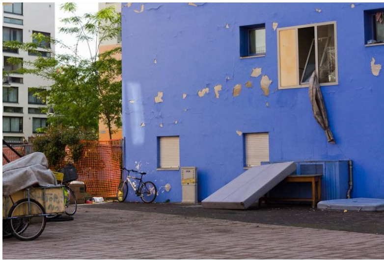
Figure 15 : L'état actuel du village olympique, 2014
