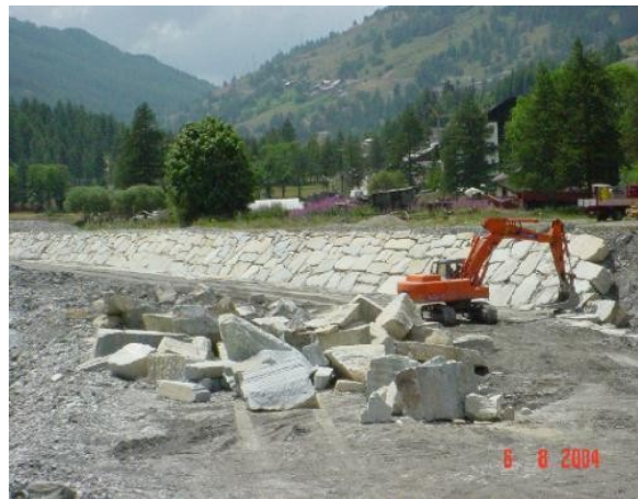
Figure 13 : Travaux pour la mesure de protection, 6 août 2004
