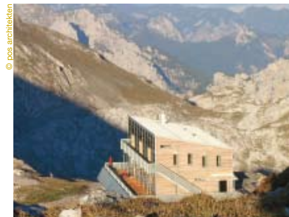
La façade Sud du Schiestlhaus et sa large surface vitrée captent de manière optimale la chaleur solaire.
