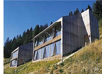
Figure 1 : Située à 900 m, la maison à absorption solaire directe de Trin (CH) se passe de système de chauffage et d'installation d'aération.
