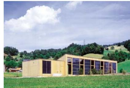
L'ensemble du bâtiment est construit en éléments de bois préfabriqués. Les parois extérieures, le toit et le sol sont construits en forme d'éléments creux, épais de 40 cm, à isolation élevée et injectés de 35 cm de flocons de papier recyclé. Le planchéage extérieur est constitué de panneaux de bois de mélèze à trois couches, du bois d'épicéa a été utilisé pour l'intérieur.
