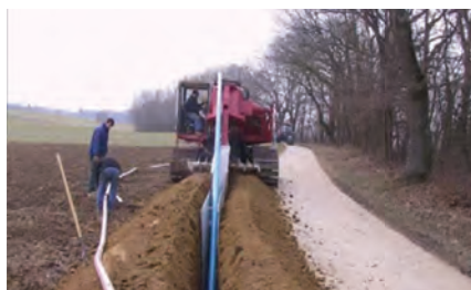
...und Verlegen der Förderrohre (Quelle: Amt für Landwirtschaft des Kantons Freiburg)
