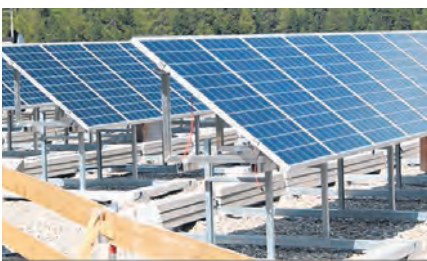
Mit der Solaranlage spart das Hotel Europa in Champèr-St. Moritz pro Jahr 25'000 Liter Heizöl (Quelle: Hotel Europa o.J.)
