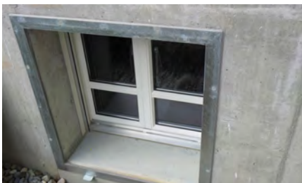
Einsparungen können beispielsweise in verbesserten Hochwasserschutz fließen.. (Quelle: Fischer Bauservice AG o.J.)
