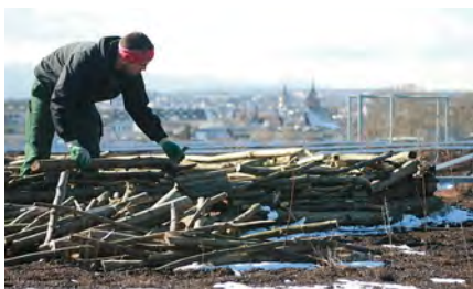
Umsetzung der Dachbegrünung auf der Messehalle Basel (Quelle: Tausenfund 2008)
