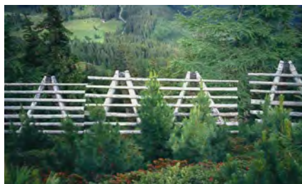
Schutzböcke als flankierende Massnahme (Quelle: Verband Österreichischer Förster 2015)
