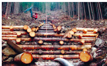
Sperrentreppen verringern das Risiko von Murgängen (Quelle: Amt für Wald und Naturgefahren 2011)
