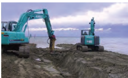
Grabungsarbeiten für das Verlegen der Zuleitung, die die Wasserfassung mit der Pumpstation verbindet...
