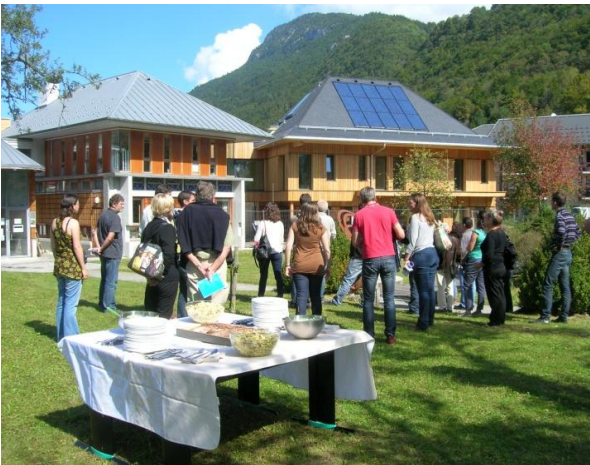
Visite de l'extension de la Maison du Parc naturel régional du Massif des Bauges
