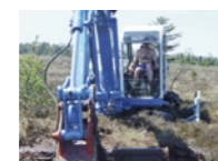
Abb. 16: Grabenverschluss mit moortauglichem Bagger
