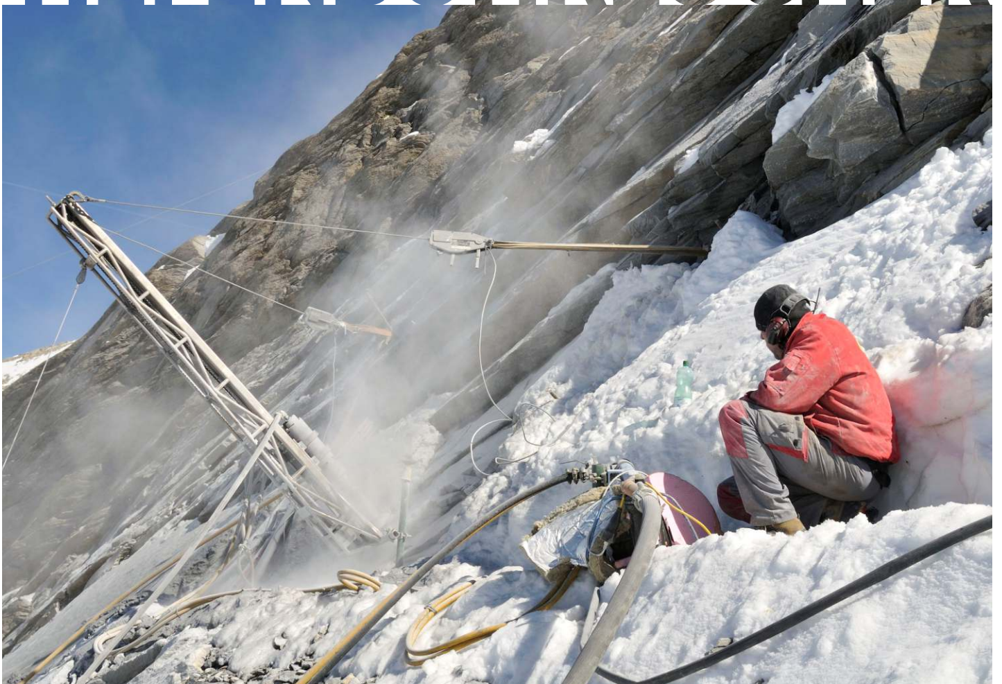
Foto: Tiefenbohrloch am Kitzsteinhorn, Ingo Hartmeyer 2010
