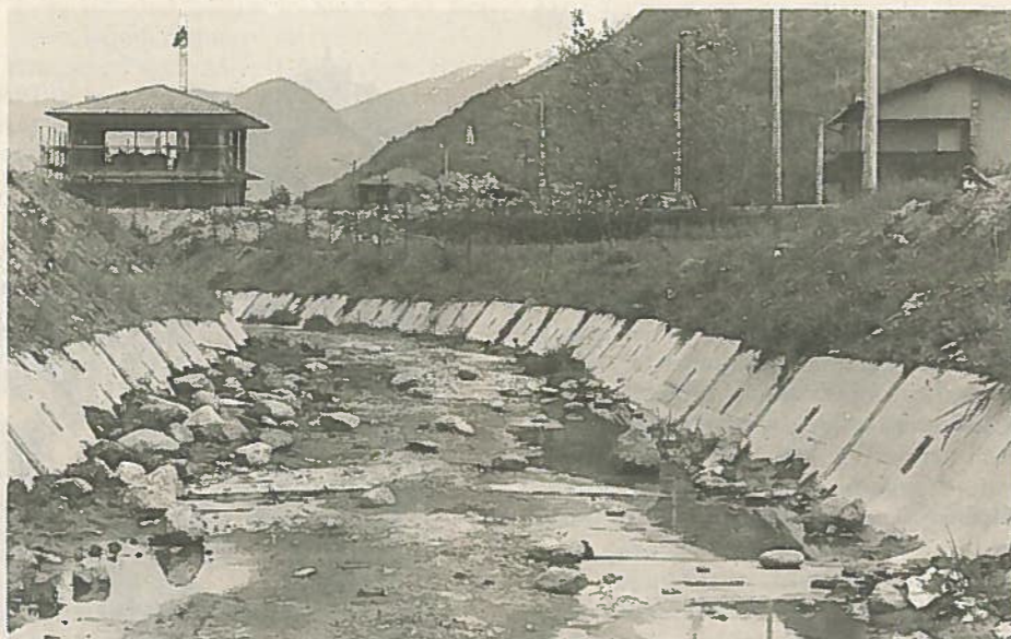
Der Fluss Adda nach den Bauarbeiten
