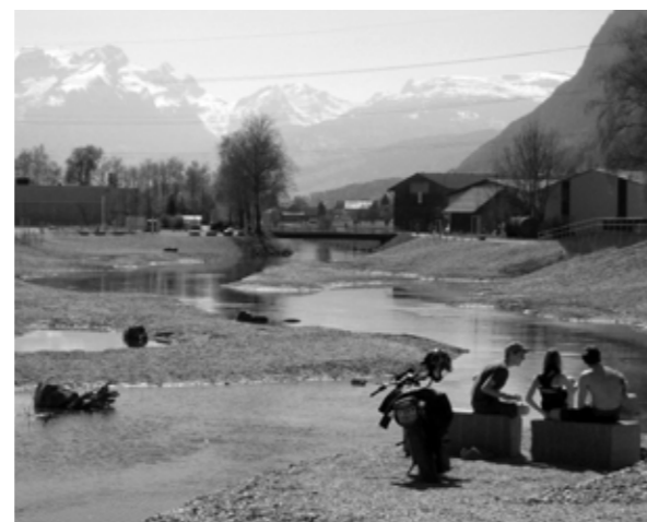
Ein multifunktionaler Raum im Entstehen – Renaturierung eines Rheintalinnenkanals, der neben Hochwasserschutz und ökologisch wertvollen Flächen ebenso eine wichtige Naherholungsfunktion bieten wird. Foto: S. Obkircher
