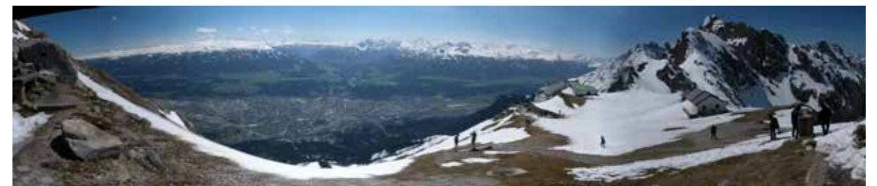
Blick vom Hafelekar auf den Zentralraum Innsbrucks. Rechts der Bildmitte die von Arch. Baumann geplante Bergstation der Seilbahn und daneben das Labor zur Höhenstrahlungsforschung, das Prof. V.F. Hess 21 errichten ließ. Unweit davon steht die renovierte Geierwallyhütte 22 , die mehrmals als Filmkulisse diente. Foto: M. Schönherr
