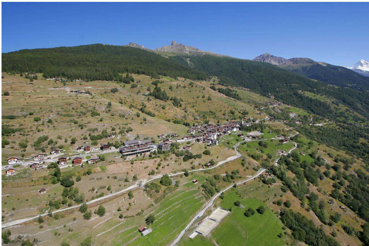
Abbildung 1 Das grosse Gebäude in der Bildmitte wird zum neuen „Maison de générations“ in St. Martin umgebaut.
