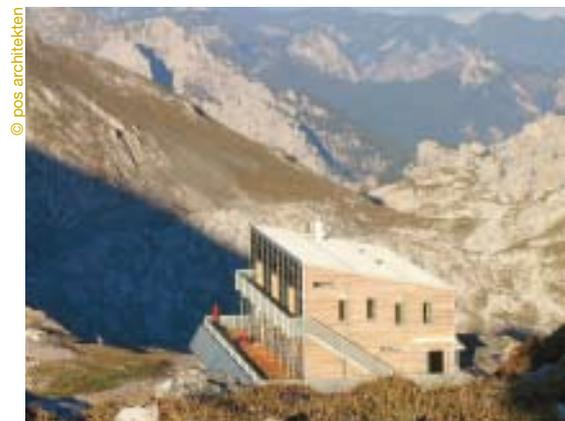
**Die grossflächig verglaste Südfassade des Schiestlhauses fängt die Wärme der Sonne optimal ein.**
