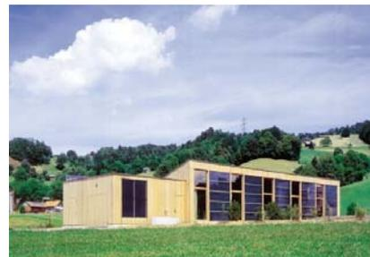
Das gesamte Gebäude ist als vorgefertigter Holz-Elementbau ausgeführt. Die Aussenwände, das Dach und der Boden sind als hochgedämmte, 40 cm dicke Hohlkasten konstruiert und mit 35 cm Altpapierflocken ausgeblasen. Die äussere Bepunktung bildet eine Dreischichtplatte aus Lärchenholz, innen wurde Fichtenholz verwendet.
