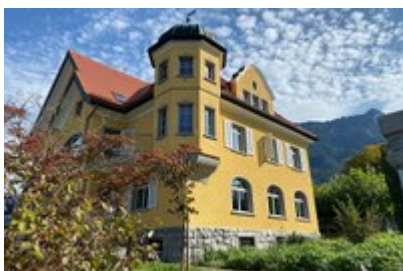
Das frisch sanierte Gebäude in Schaan/LI ist das neue Zuhause von CIPRA International und ein Zentrum für nachhaltiges Engagement. (c) Caroline Begle, CIPRA International
