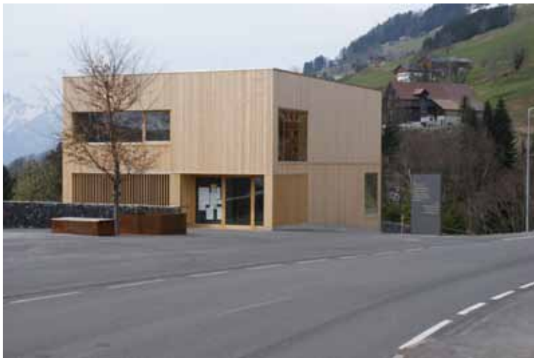
Vorarlberg ist Vorreiter beim energiesparenden Bauen. Im Bild das erste BERG-HOLZ Passivhaus – Gemeindezentrum St. Gerold; ©Ingeborg Schmid-Mummert.
