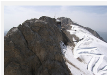
Piattaforma d'arrivo sulla Marmolada, con la strada, costruita appositamente per i lavori di revisione della funivia. © Mountain Wilderness Italia
