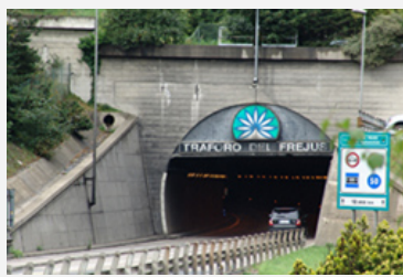
I lavori per il raddoppio del tunnel del Frejus inizieranno entro quest'anno.
