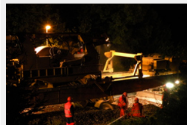
Die Brenner-Bahnachse samt Zulaufstrecken soll ausgebaut werden.
