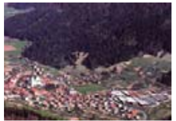
Gemeinde Gornji Grad mit Fernwärme-Heizwerk (rechts)
