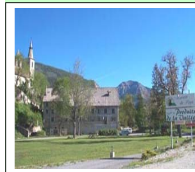
La Maison de Pays profite désormais du chauffage bois-énergie
