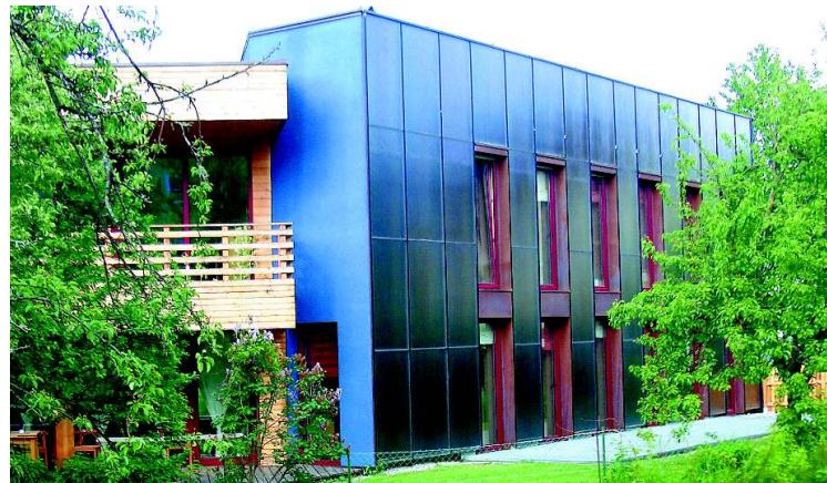
Der Fassadenkollektor des AEE Büro-Passivhauses in Villach versorgt gemeinsam mit einer Pelletsheizung im Keller 16 Wohnungen in der Nachbarschaft mit Wärme
