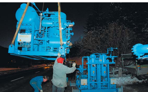
Installation of the heat pump. Montaggio della pompa a calore.
